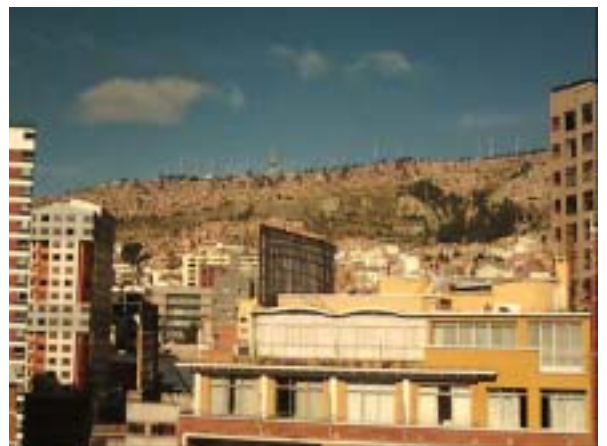
ラパス市内から望む放送所
