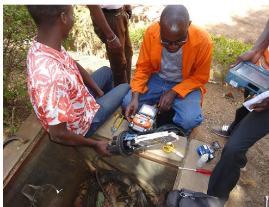
住友電工製の心線融着接続機を使った作業
