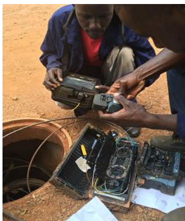
フジクラ製の心線融着接続機を使った作業
