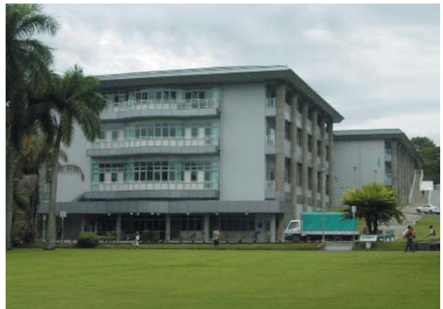
写真1. 完成されたICT Center2棟
